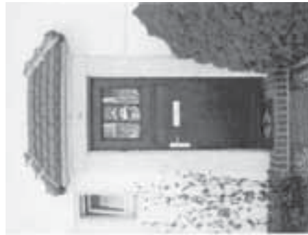
Abb 5 Beispiel für Türgewand mit abgedecktem Vordach
